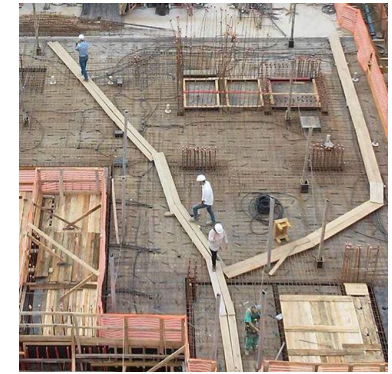
Ilustração 19.9.4: Área isolada e sinalizada para descarga de vergalhões.
